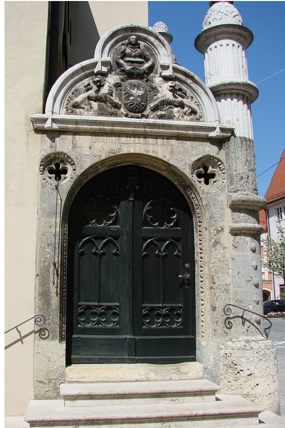
Bauwerk aus Suevit (Portal zur Treppe des Nördlinger Rathauses)
