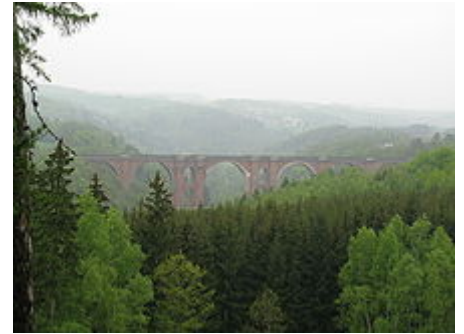
Die Elstertalbrücke vom Eisenberg aus gesehen
