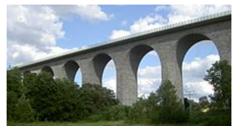
Die Autobahnbrücke bei Pirk
