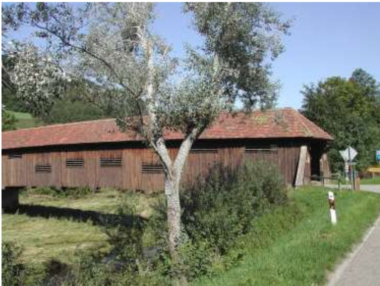
Holzbrücke in Unterreggenbach
