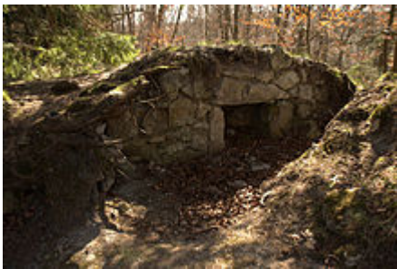
Bild 2: Letzter sichtbarer Mauerrest, vermutlich ehemaliger Bergfried
