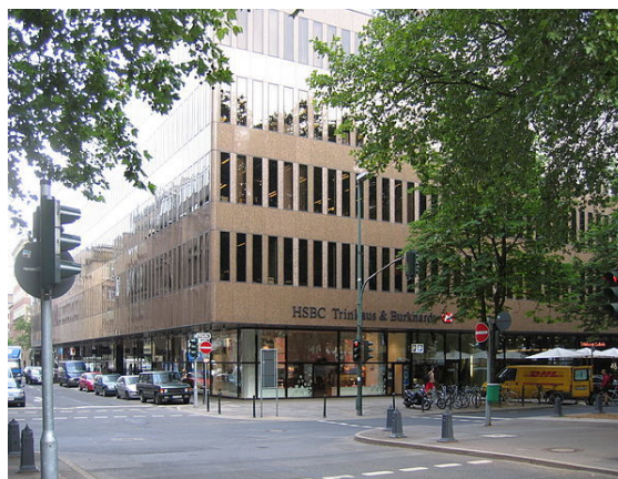
Ein Beispiel für den Granit Gotenrot als Fassadenbekleidung am Trinkaus-Gebäude in Düsseldorf
