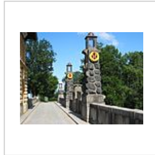
Schleuse am Moldaukanal
