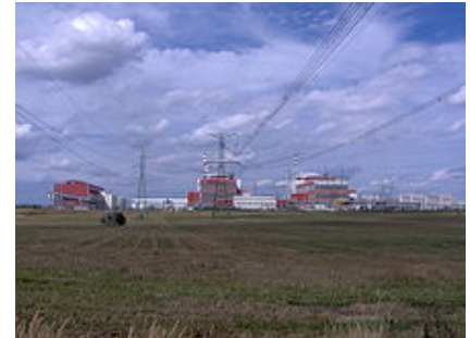
Die beiden Reaktorgebäude
