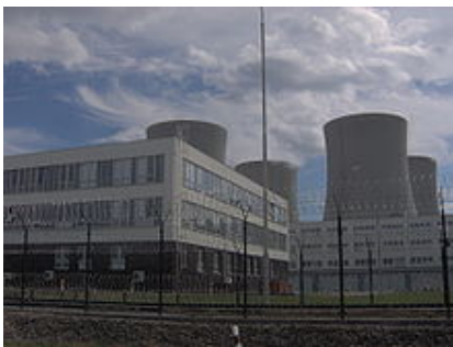
Die Kühltürme und der Sicherheitszaun des Kraftwerks
