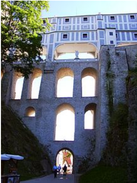
Mantelbrücke, von Norden aus gesehen
