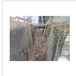
Überreste der Seilbahn zum Dreikreuzberg (2011)
